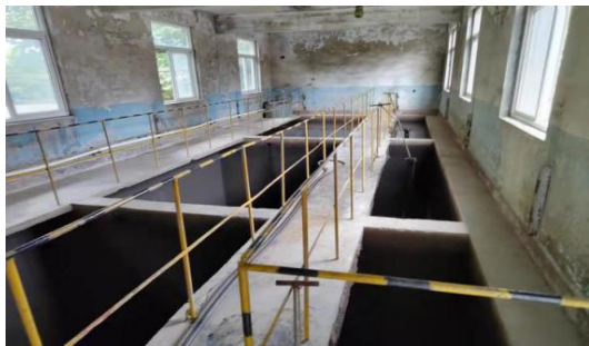
含银废水处理（絮凝沉淀池）
