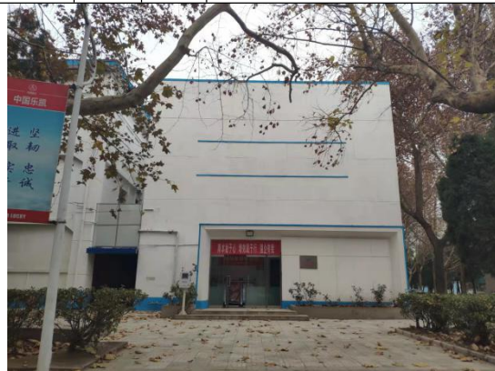
医疗影像乳剂车间
