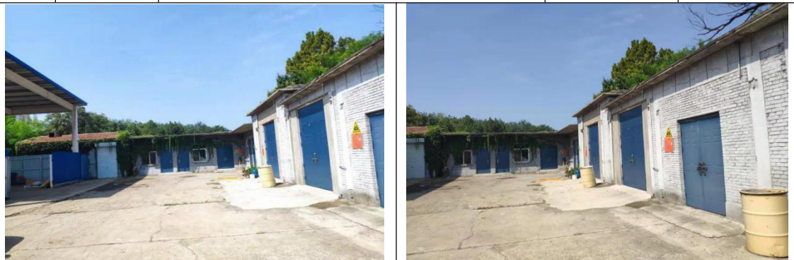
乐凯集团危废暂存库区
