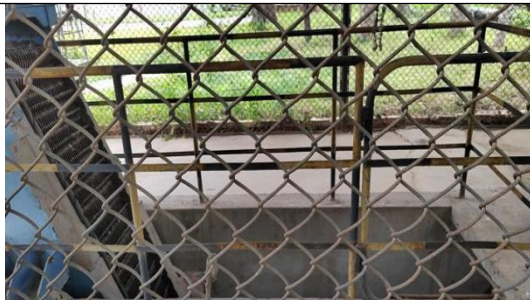
中水处理（集水池）
